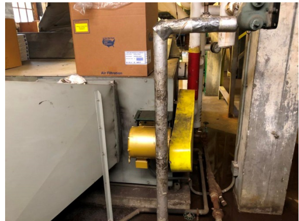
013C AHU-002 Fan Coil Section
